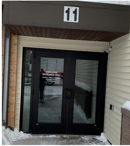
Door #11 Concrete Stoop
