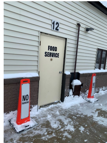
Door #12 Concrete Stoop
